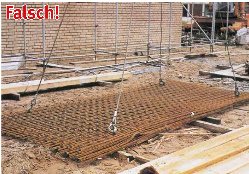
Bild 16-5: Einhängen in die Umschnürung ist lebensgefährlich!
