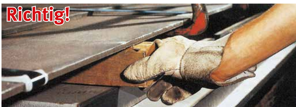
Bild 20-2: So wird ein Unterlegholz richtig angefasst. Die Finger sind nicht gefährdet
