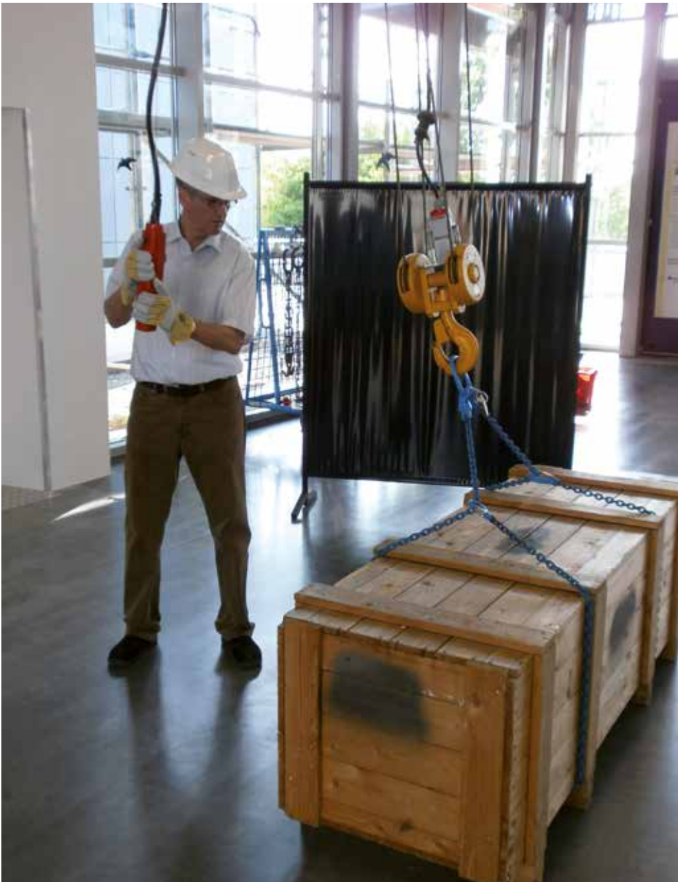
Bild 18-1: Vorsicht Pendelbewegung – Der Kranführer hat darauf zu achten, dass sich der Kranhaken über dem Lastschwerpunkt befindet und kein Schrägzug ausgeübt wird.
