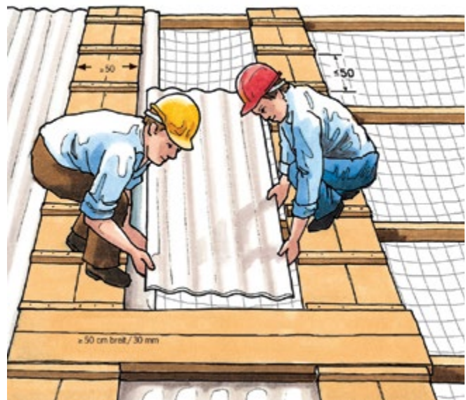
Abb. 3.5.2-04 Dachdeckung mit Wellplatten
