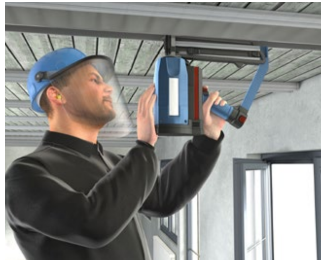
Abb. 3.3.7-03 Eintreibgerät mit Auslösesicherung
