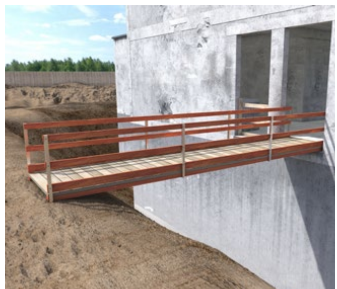
Abb. 3.5.2-03 Laufsteg mit Seitenschutz als Verkehrsweg
