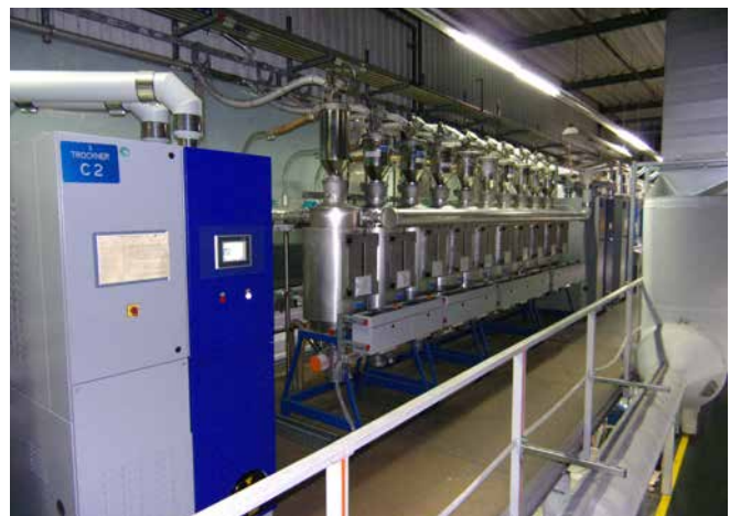
Abb. 72 Beispiel für eine zentrale Materialversorgung
