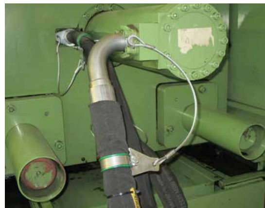
Abb. 57 Best Practice einer nachgerüsteten Fangsicherung für Druckschläuche
