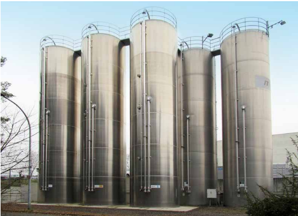
Abb. 67 Silos für Kunststoffgranulat
